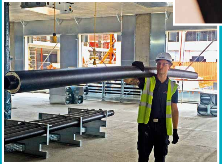
COOL-FIT 2.0: GF Piping Systems’in hafif, hazır izolasyonlu ve korozyonsuz çözümü. Montajcılar metrelerce uzun parçaları kolayca omuzlayabiliyor.
